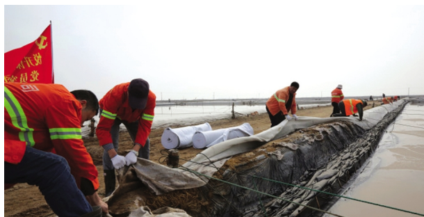
徐圩投资公司围绕“1+1”先锋工程,组织基层支部200余名党员帮助制盐马二份分公司实施更换池堰土工布工程。(徐宣)
